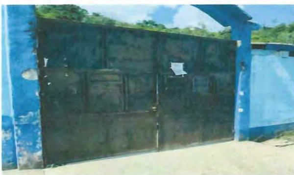
Foto 4: Sustrución del Porton de Metal en la entrada del establecimiento para garantizar el resguardo de los alumnos y de los bienes.
