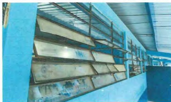
Foto 3: Instalación de balcones de metal en las ventanas de los módulos que no cuentan con esa protección para evitar daños en los vidrios.
