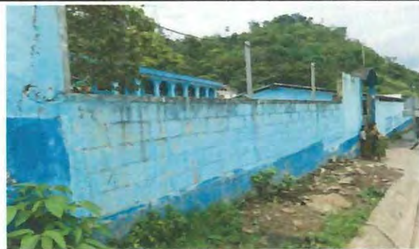
Foto 5: Sustrución de malla galvanizada de la parte superior del muro perimetral con instalación de balcones de metal para garantizar mayor seguridad en esa área.
